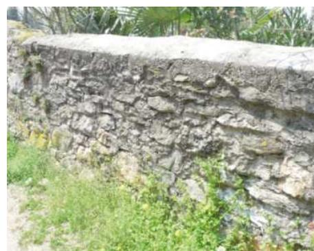
Il muro è stato consolidato utilizzando un legante a base di calce aerea per limitare gli interventi di manutenzione. La soluzione è accettabile: i giunti di malta non alterano troppo la morfologia originaria. Tuttavia il muro è stato dotato superiormente di un corridoio cementizio, preferibilmente da evitare.
